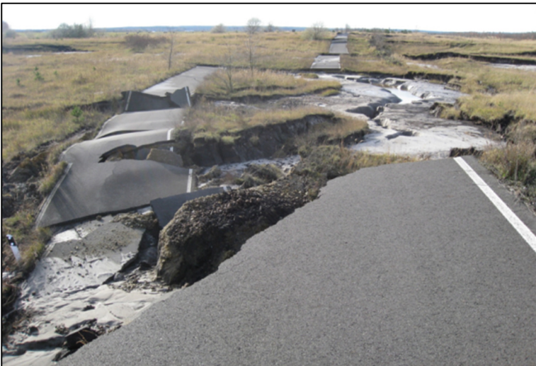
Abbildung 1: Beispiel für eine Geländedeformation (Foto; LMBV)
